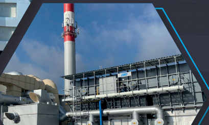
Dopalcz termiczny RTO 3k, V = 85,000 Nm 3 /h, produkcja materiałów drewnopochodnych, łódzkie
