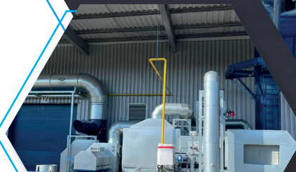
Koncentrator LZO KZY 30 w kombinacji z dopalaczem katalitycznym DKT 1.2, V= 30,000 Nm 3 /h, przemysł samochodowy, dolnośląskie
