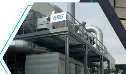
Koncentrator LZO w kombinacji z dopalaczami RTO (2szt), V = 78,000 Nm 3 /h, przemysł opakowaniowy, podkarpackie
