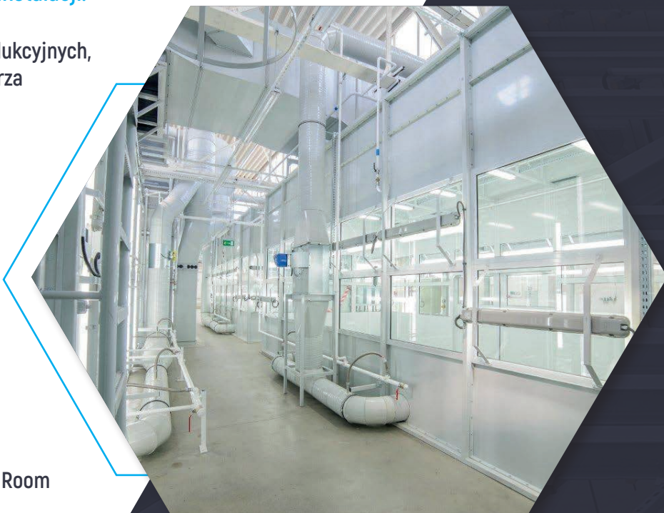
Wentylacja i klimatyzacja malarni elementów lotniczych, 75 000 m 3 /h, przemysł lotniczy, podkarpackie
